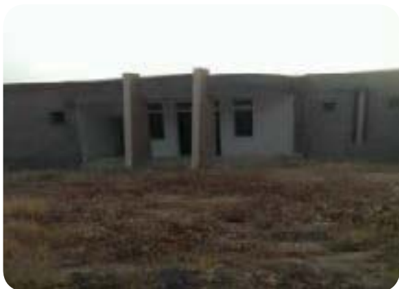
Café en cours de construction
